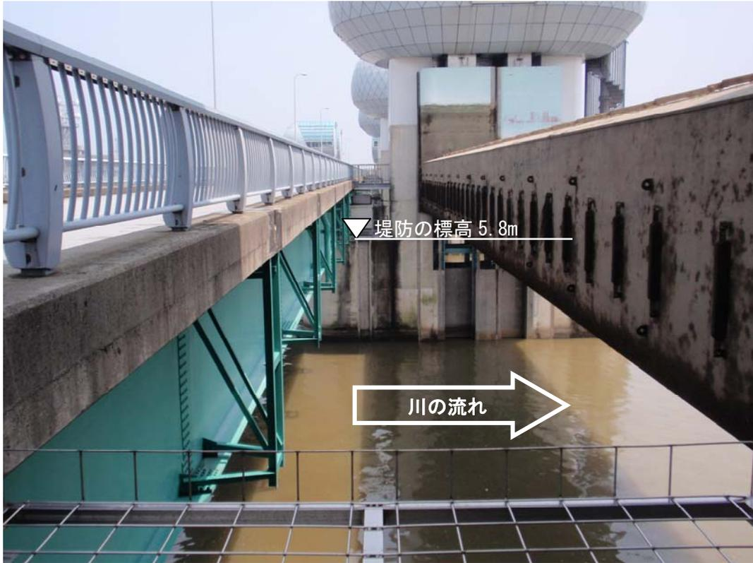
ゲート全開操作の長良川河口堰（堤防より高い位置にゲートを引き上げ）
